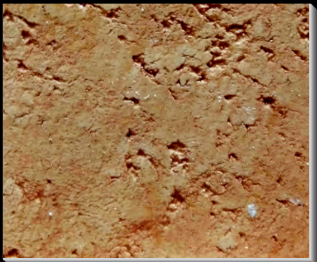
Muro Fossa MUF-1123
